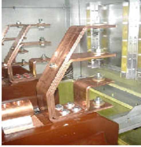
Resim 4.1: Bara yüzeylerinin tam teması için vida ve somunlarının çok iyi sıkılması
