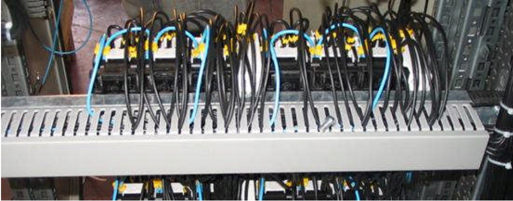
Resim 4.2: Kanal içine yerleştirilme işlemi tamamlanmış kablolar
